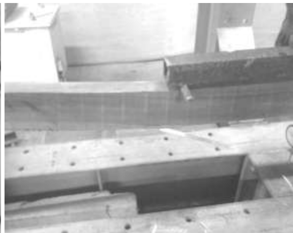
Gambar 4.4. Kerusakan pada BTS
